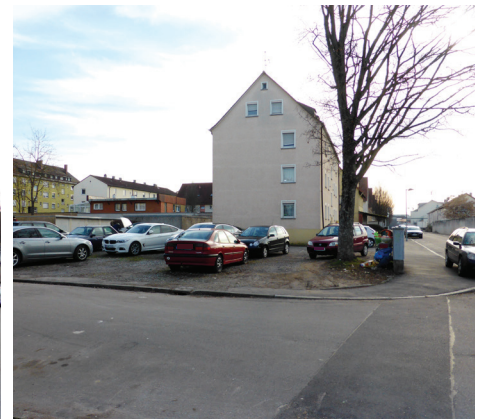
Abb. 87: Baulücke mit Zwischennutzung
