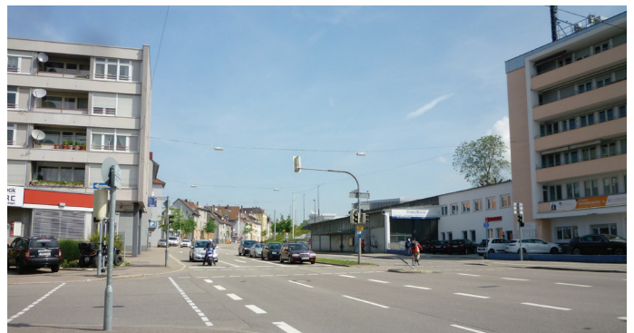
Abb. 14: Hochpunkte am Beginn der Neckarsulmer Straße
