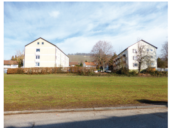
Abb. 31: Zeilenbebauung an Freihaltetrasse
